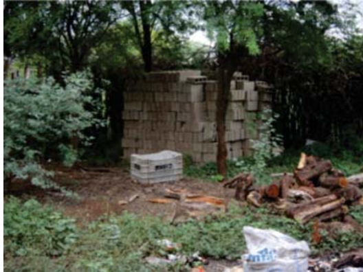
Foto 13. Fábrica de artefatos de cimento (bloquetes).
